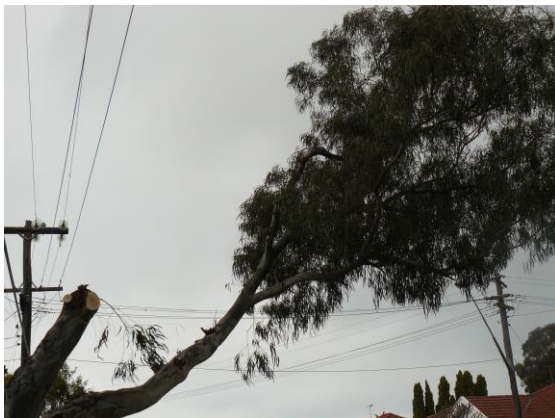
Recent Ausgrid Pruning
